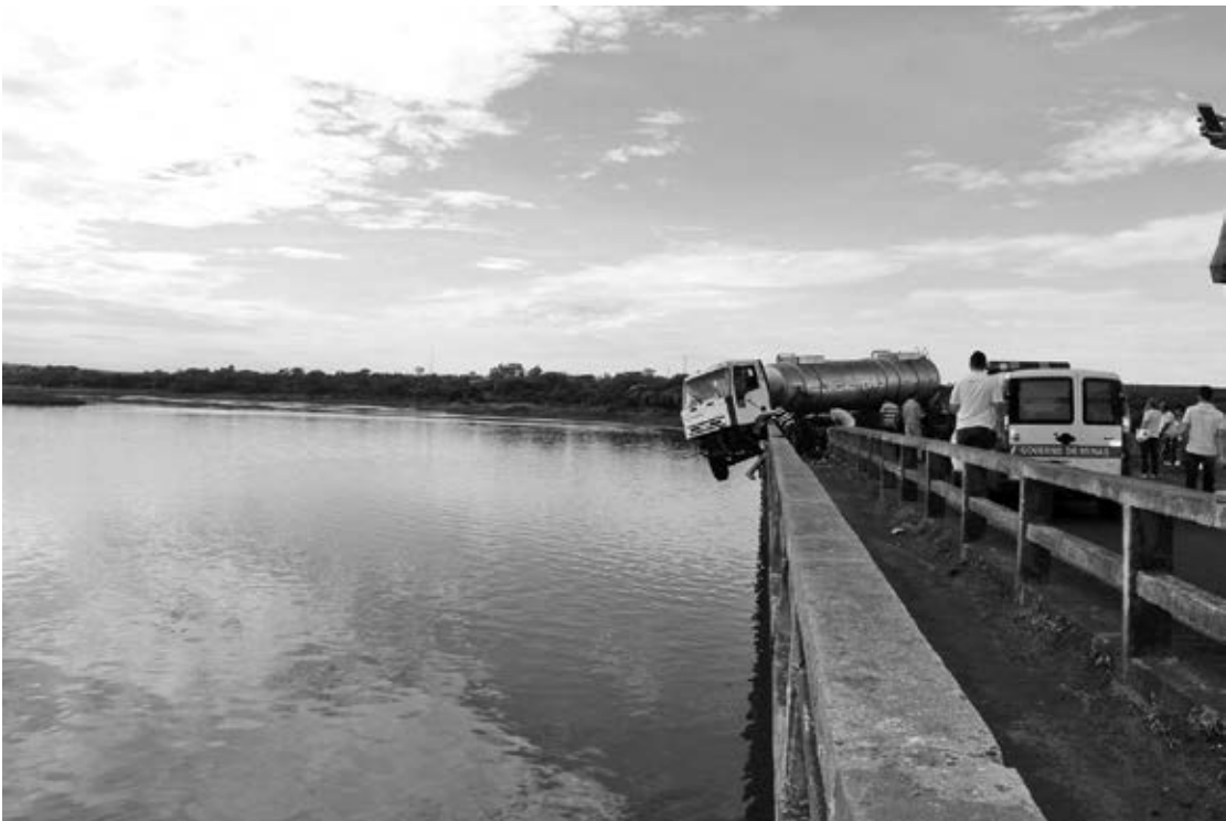
No final de janeiro deste ano, um acidente envolvendo um caminhão tanque e um veículo de passeio danificou o parapeito da ponte no sentido Colômbia (SP) e Planura (MG) (Foto: Notícias News)
