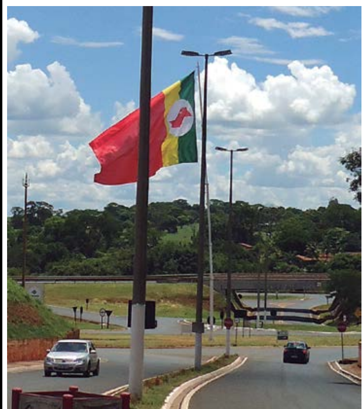
O mastro da Bandeira de Barretos , na entrada da cidade pela avenida 43, na junção com a Avenida José Ducati, se apresentava completamente torto no final da tarde desta sexta-feira (14). Motoristas que circulavam pelo local apontaram perigo nesta época de fortes chuvas, acompanhadas de ventania constante, além de reparos imediato por parte da administração municipal.
